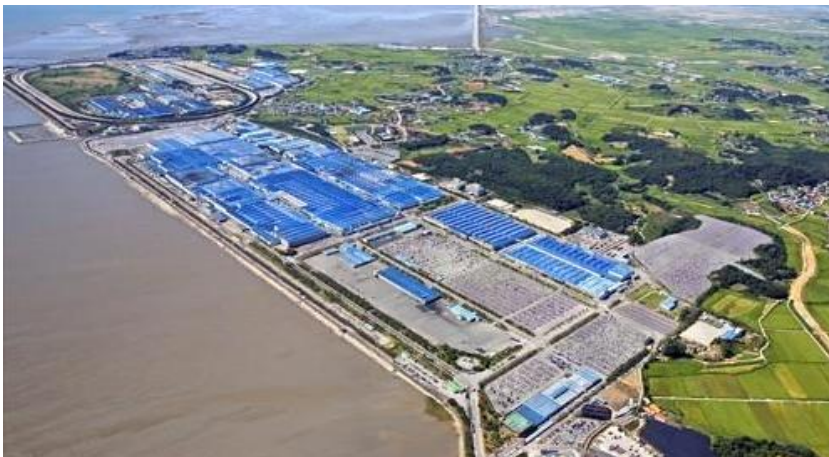
기아 오토랜드 화성 전기차(PBV) 공장 증설
