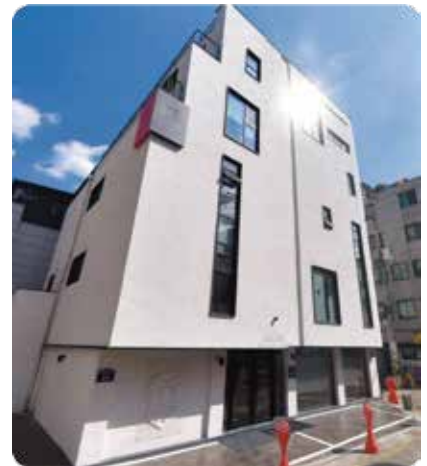
벽돌 구조 빌딩 리모델링
